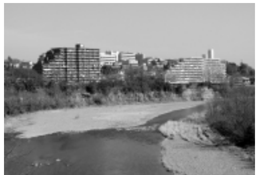
写真2 多摩川沿いのマンション群
