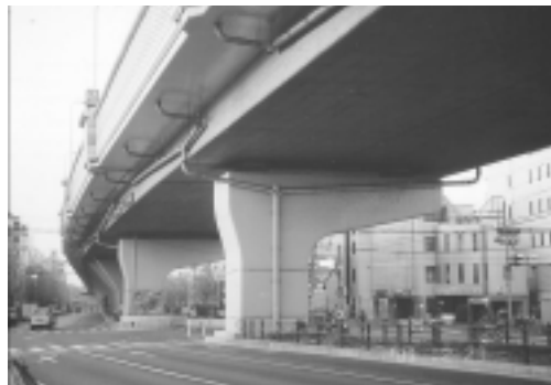
写真2 逆L字型橋脚
