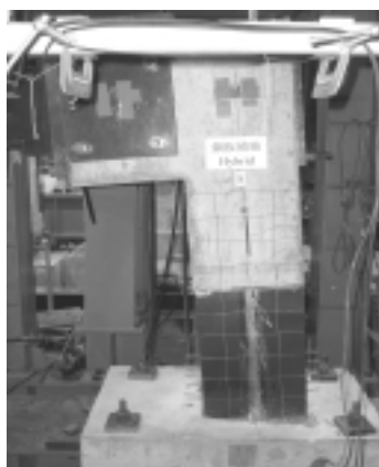
写真3B 鋼板による補強
