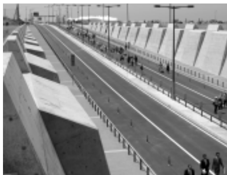
新潟みなとトンネル左岸部
